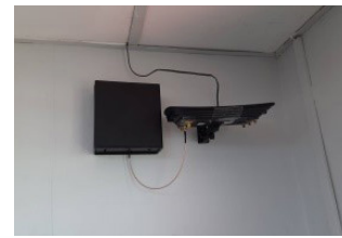
(ข) การทดสอบระบบร่วมกับสายอากาศต้นแบบรูปที่ 24 การติดตั้งสายอากาศงานวิจัยนี้เพื่อทดสอบ
