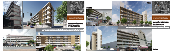
อาคารพักอาศัยรวมของเจ้าหน้าที่ตำรวจภูธร อาคารพักอาศัยรวมเรือนจำบางขวาง
