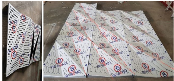
รูปที่ 12 การวางแนวรอยต่อระหว่างแผ่นพับแต่ละชิ้นก่อนติดตั้งกับอาคาร
