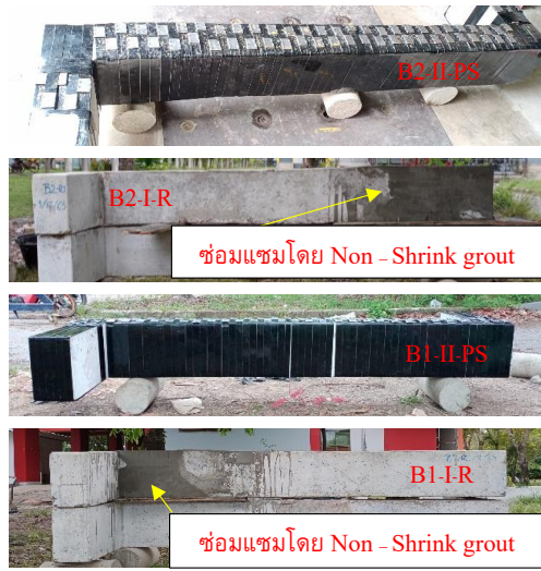
รูปที่ 5 การเสริมกำลังและซ่อมแซมคานคอนกรีต
