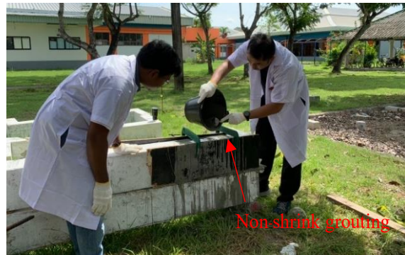
รูปที่ 2 การซ่อมแซมคานคอนกรีตหลังจากผ่านการทดสอบจากระยะที่ 1 โดยคอนกรีตกำลังอัดสูง
