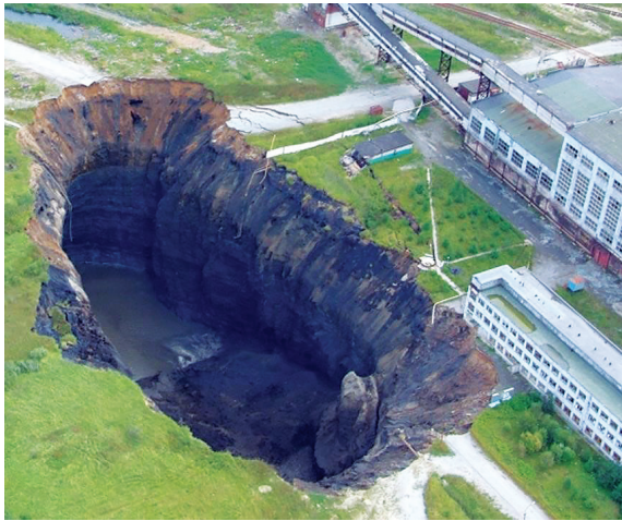
รูปที่ 4 การเกิดหลุมยุบครั้งใหญ่ในเมืองเกลือบโปแตซใน แคว้นเปิร์ม ทำให้เมืองต้องใช้กระบวนการติดตาม การเกิดหลุมยุบแบบเวลาจริง [13]
