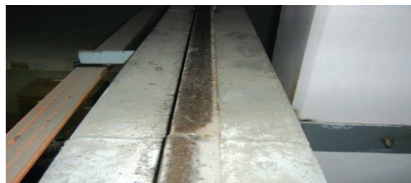
รูปที่ 3 รางวิ่งชนิดสี่เหลี่ยมตันบนสะพานเครน
