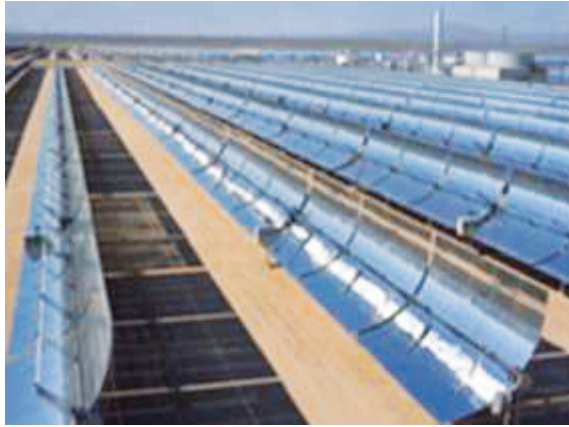
รูปที่ 4 แผ่นรวมแสงแบบรางพาราโบลา [11]
