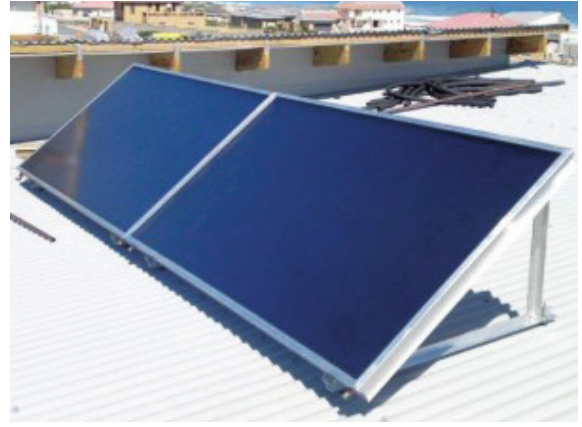
รูปที่ 5 แผ่นรับแสงแบบแผ่นเรียบ [12]
