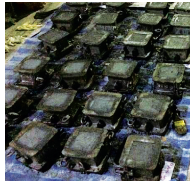
(ข) เทคอนกรีตในแบบหล่อ
