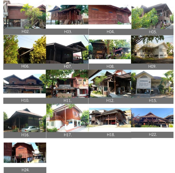
รูปที่ 5 อาคารกลุ่มที่ 2 อาคาร 1 ชั้นยกใต้ถุนสูง
