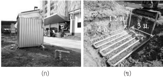
รูปที่ 12 โรงเรือนเพาะเห็ดและระบบทำความเย็นแบบท่อใต้ดินที่สร้างจริง
