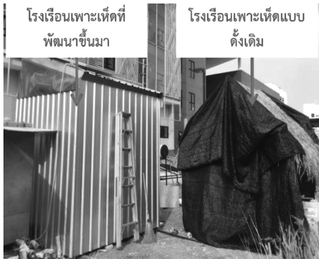
รูปที่ 20 โรงเห็ดที่ติดตั้งระบบทำความเย็นแบบท่อใต้ดินพร้อมระบบพ่นหมอกอัตโนมัติ และโรงเพาะเห็ดแบบดั้งเดิมที่ใช้ในการทดลอง
