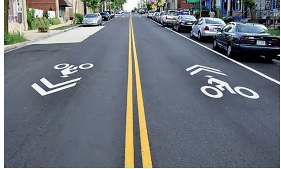
รูปที่ 4 ทางจักรยานรูปแบบ C แบบกว้าง และสัญลักษณ์ [6]
