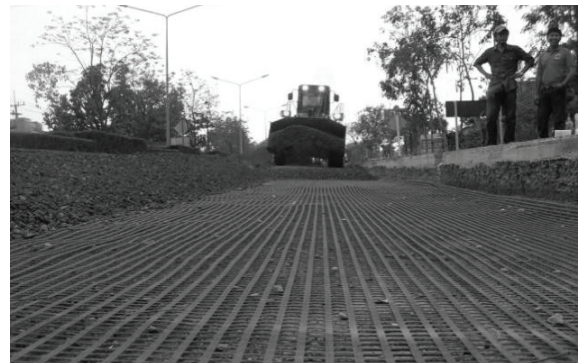
(ค) การเสริมแรงถนนด้วยวัสดุ Geogrid
