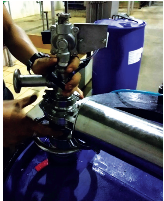
รูปที่ 16 การติดตั้งชุดฝาถังพร้อมมวล
