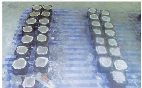
(ข) เทคอนกรีตในแบบหล่อ
