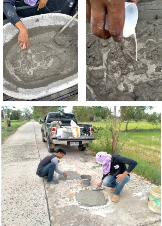
รูปที่ 8 ผิวการจราจรที่ทำการซ่อมแซม
