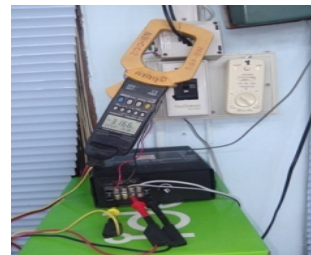
รูปที่ 6 ติดตั้งชูวัดค่ากำลังไฟฟ้า
