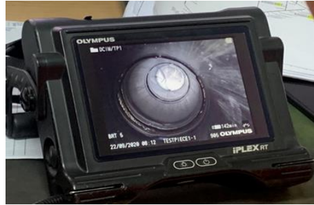
รูปที่ 5 การตรวจสอบในท่อด้วยกล้องงู
