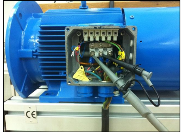
รูปที่ 3 แสดงการวัดแรงดันที่ขั้วมอเตอร์
