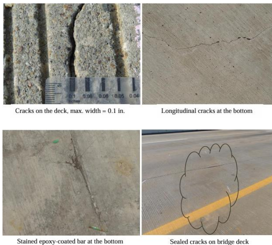
รูปที่ 1 ความเสียหายของพื้นสะพาน
