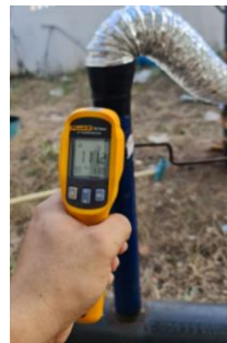
รูปที่ 8 การวัดระดับอุณหภูมิของอากาศที่ไหลผ่านมาจากอุปกรณ์อุ่นอากาศ
