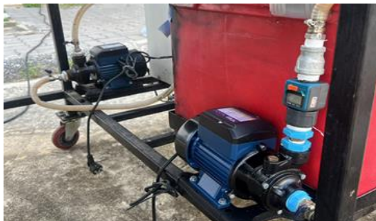
รูปที่ 6 ติดตั้งปั้มน้ำที่โครงสร้าง 2 ตัว
