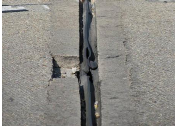
รูปที่ 1 บารองรับรอยต่อพื้นสะพานขณะเกิดความเสียหาย Carroll และ Juneau [2]
