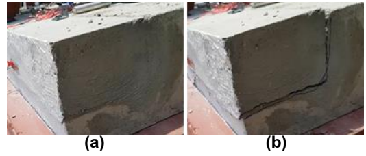
รูปที่ 5 ปารองรับรอยต่อพื้นสะพานก่อนและหลังทำการทดสอบ
