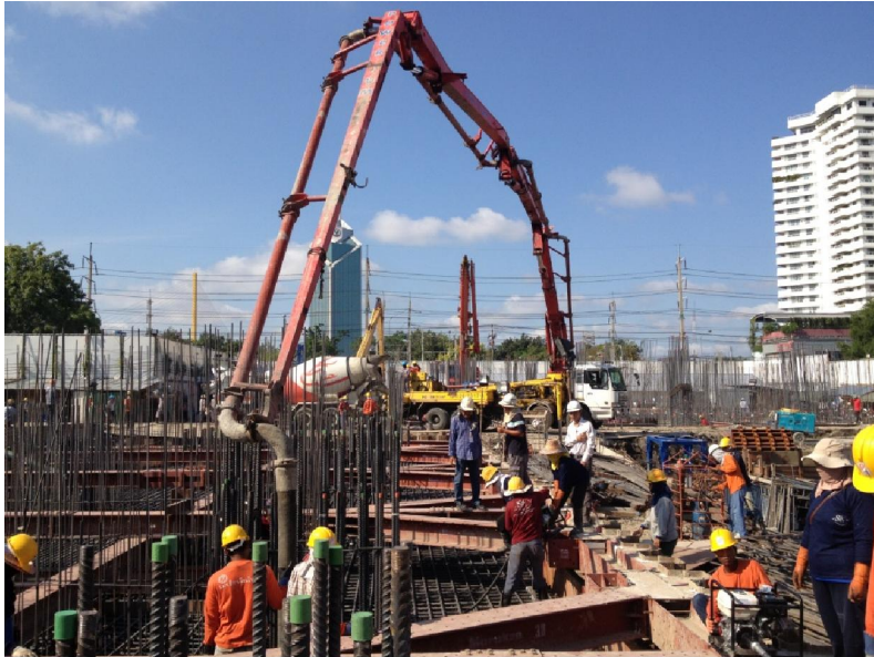
รูปที่ 10 การเทคอนกรีตผ่านบีมคอนกรีต
