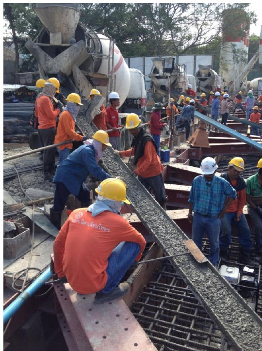
รูปที่ 11 การเทคอนกรีตด้วยราง PVC
