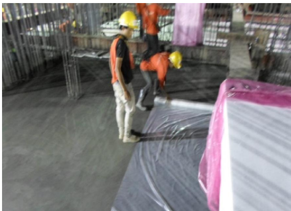
รูปที่ 13 การปูแผ่นพลาสติกและคลุมด้วยแผ่นโฟมเพื่อใช้เป็นฉนวนป้องกันความร้อนในการบ่มคอนกรีต
