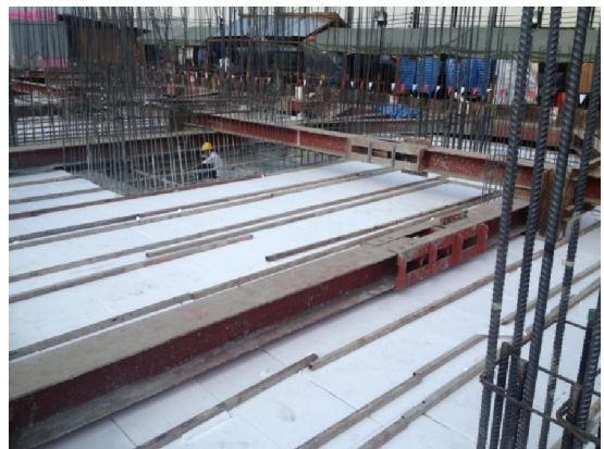
รูปที่ 13 การปูแผ่นพลาสติกและคลุมด้วยแผ่นโฟมเพื่อใช้เป็นฉนวนป้องกันความร้อนในการบ่มคอนกรีต
