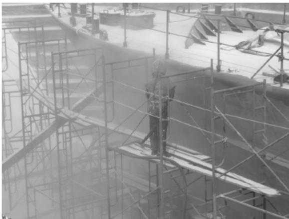
รูปที่ 4 การพ่นทราย (Sand Blasting) [15]
